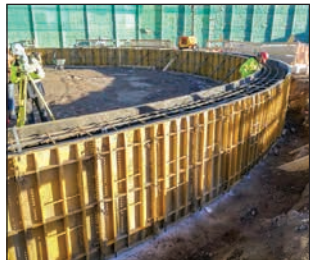
Extensión Metro Línea 2, Comuna San Bernardo, Chile
