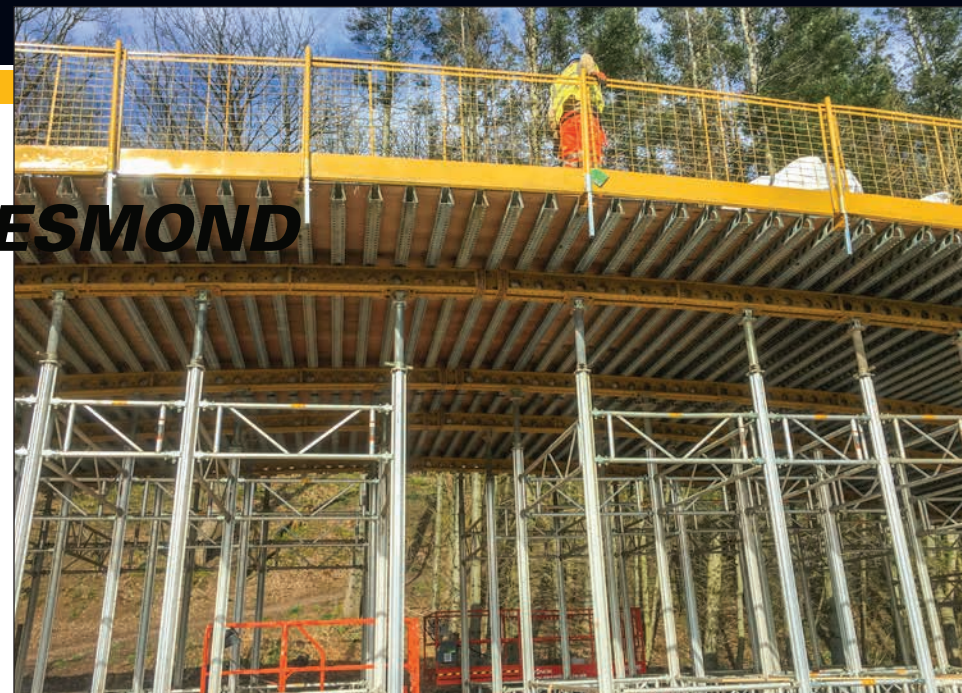
Las torres de apuntalamo E-Z DECK® de EFCO soportaron el arco del puente durante la construcción.
