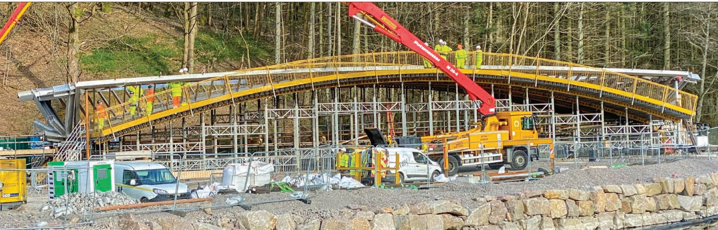
Las torres de apuntalamo E-Z DECK® de EFCO soportaron el arco del puente durante la construcción.
