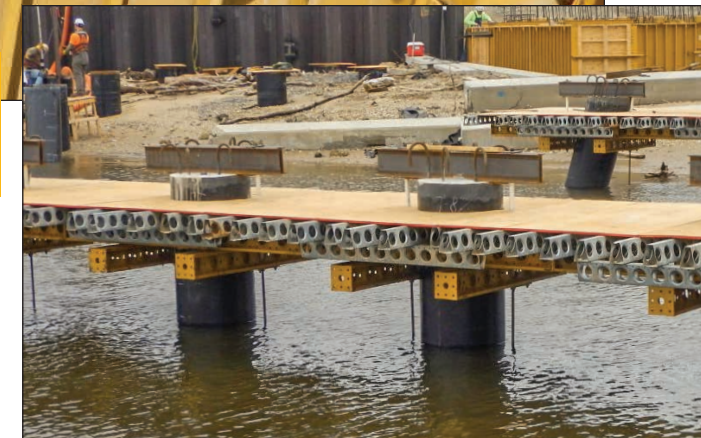
Se utilizaron encofrados PLATE GIRDER® con Gatos de Apoyos EFCO y accesorios SUPER STUD® y E-BEAM® .
