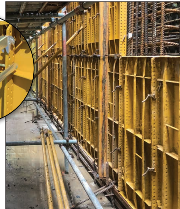
La herramienta PICO EFCO está diseñado para alinear fácilmente los PANELES MANUALES de EFCO. Una vez que los agujeros de los paneles se han alineado, la Grapa EFCO, con su pasador troncocónico y su mandíbula, se pueden insertar en la ubicación apropiada del agujero de brida y sujetar para que calce ajustado.
