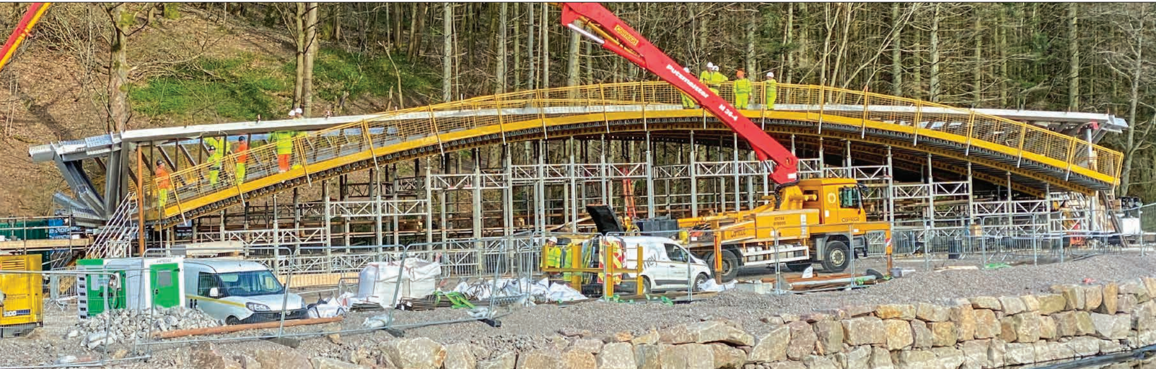
Las torres de apuntalamiento E-Z DECK® de EFCO soportaron el arco del puente durante la construcción.
