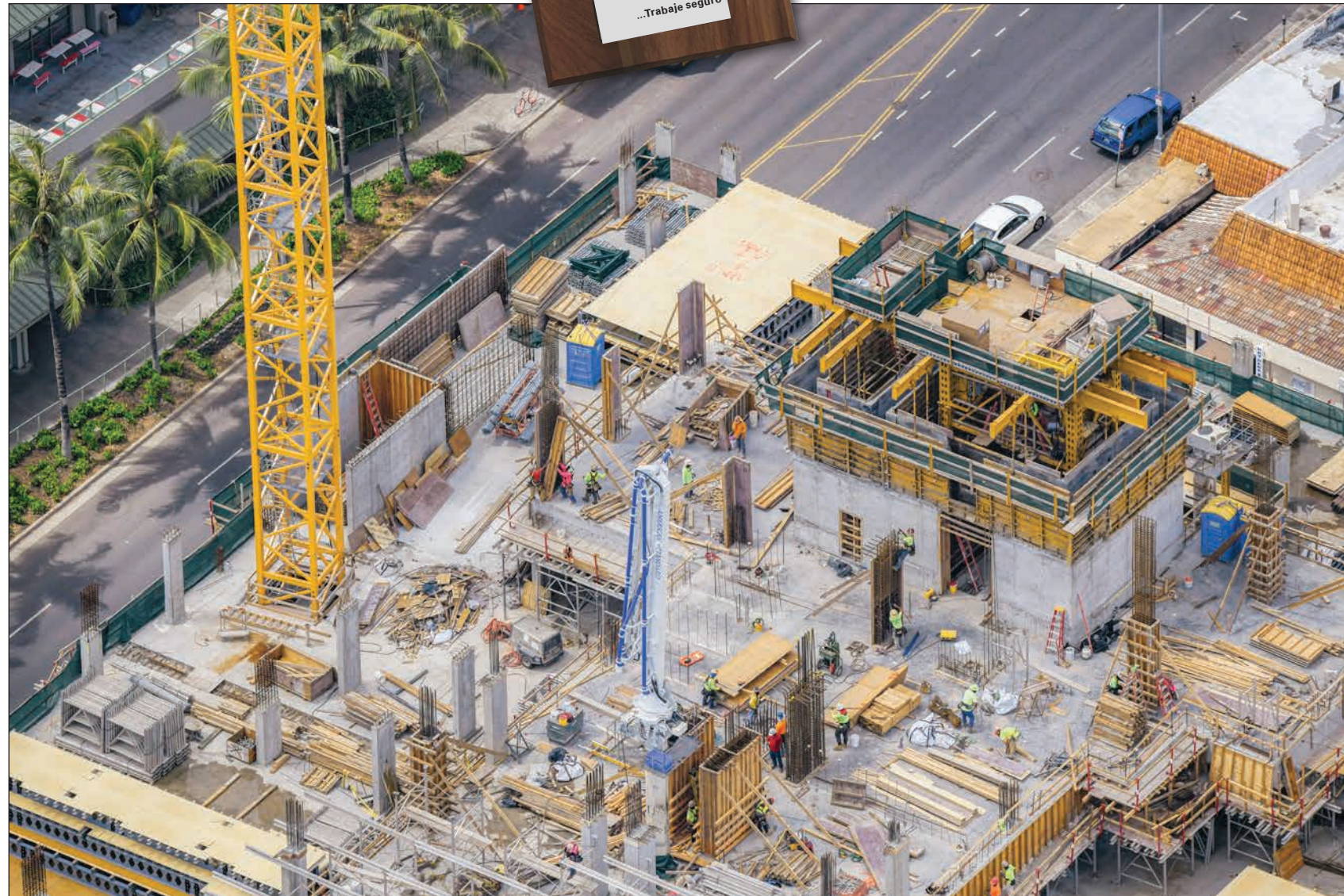
Con la gran capacidad de POWER TOWER ® PT-100, Albert C. Kobayashi, Inc. pudo también utilizar la cubierta superior como plataforma de trabajo y de depósito.
