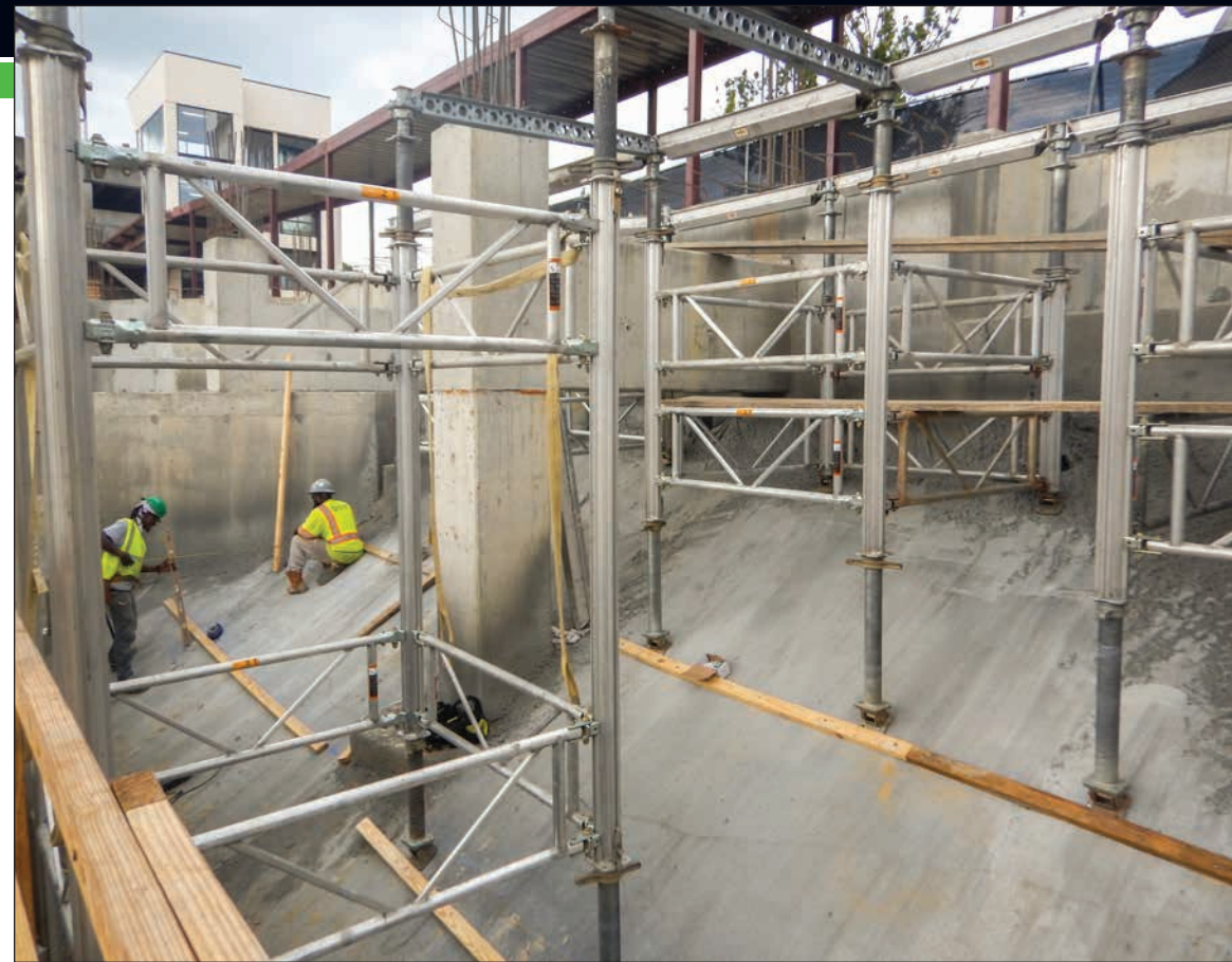
Para la base inclinada, la solución de EFCO fue agregar el Adaptador Cabezal Basculante EFCO a la parte inferior de los postes E-Z DECK® para estabilizar las torres de apuntalamiento y soportar la losa de 300 mm (12").
