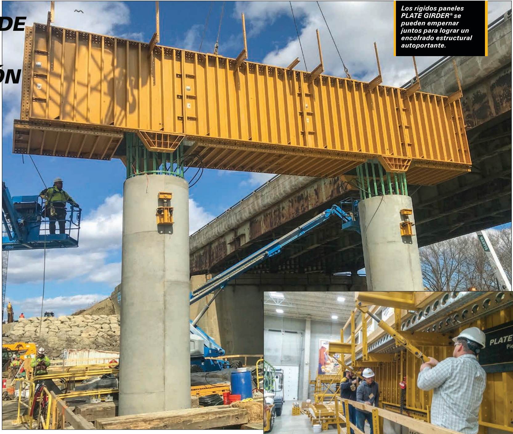
Una visita al Instituto de EFCO le permitió a SPS New England, Inc. tener una orientación y práctica en la rotación de una viga cabezal de tamaño real en un lugar cerrado.
